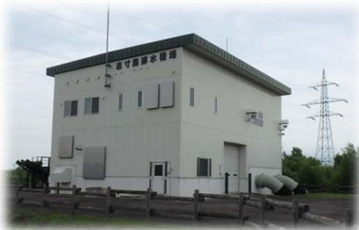
志寸島排水機場
