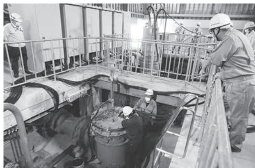
ポンプ設置訓練
