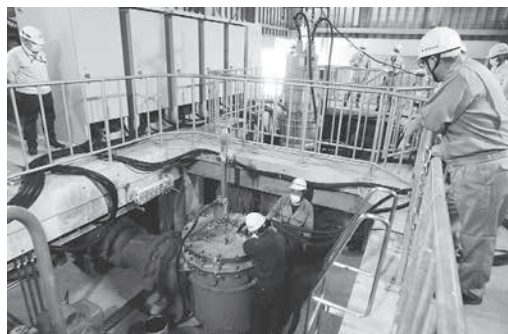
ポンプ設置訓練
