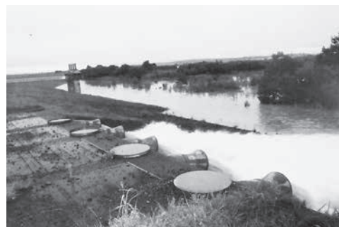
平成30年7月の排水状況（石狩川）
