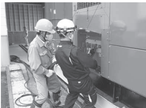
ポンプ稼働のための発電機設置
