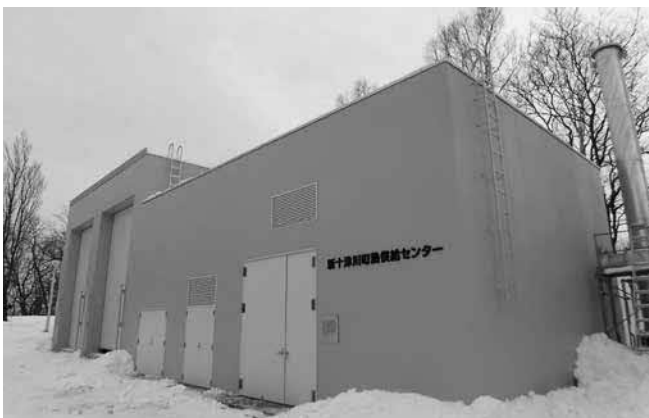
▲熱供給センター外観
