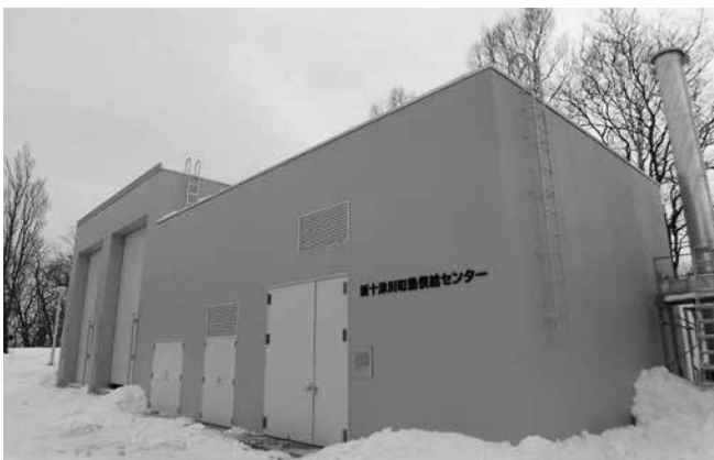
▲熱供給センター外観
