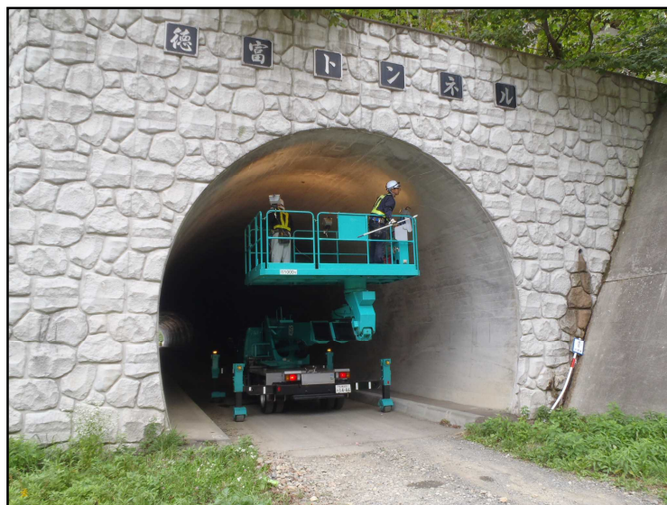
平成28年9月 定期点検状況
