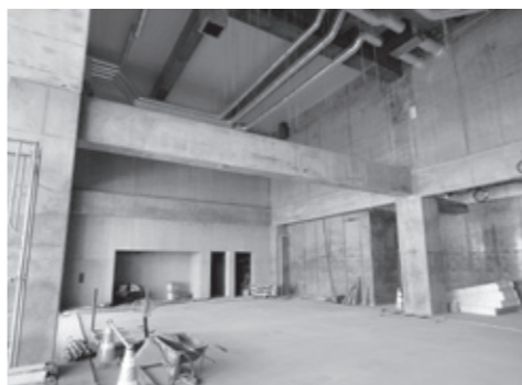
新庁舎内部の工事状況
