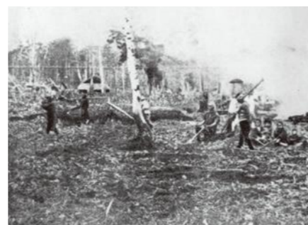
開墾する様子。作業は困難を極めた。 (明治23年 北海道 新十津川町)
