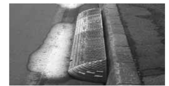
段差解消ブロック
