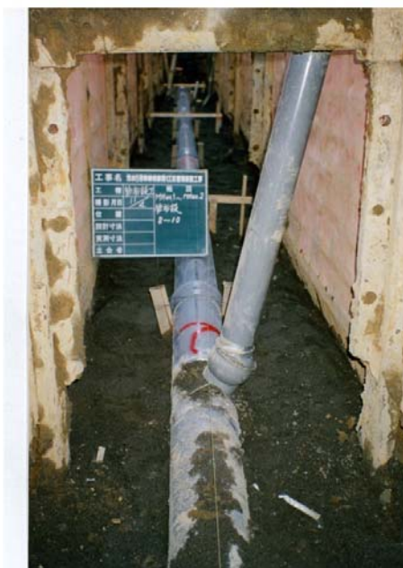
管渠施工の様子
