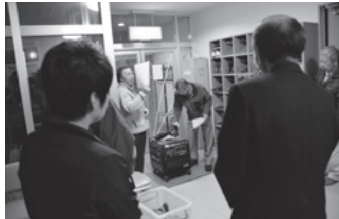
△発電機の操作説明
