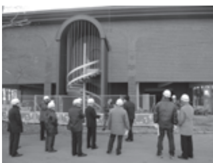
改修工事中の開拓記念館
