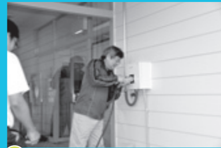
2 非常電源接続コンセントにつなぐ
