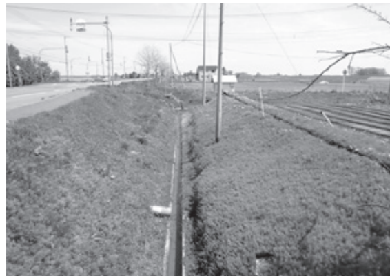
国道275号（大和区）のトラフ化されている側溝
