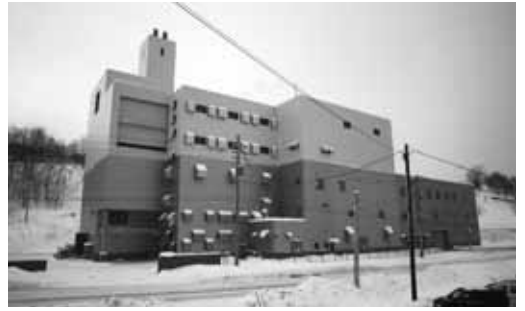
可燃ゴミ焼却処理施設エネクリーン
