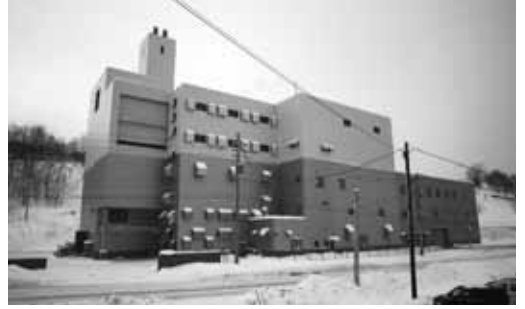
可燃ゴミ焼却処理施設エネクリーン
