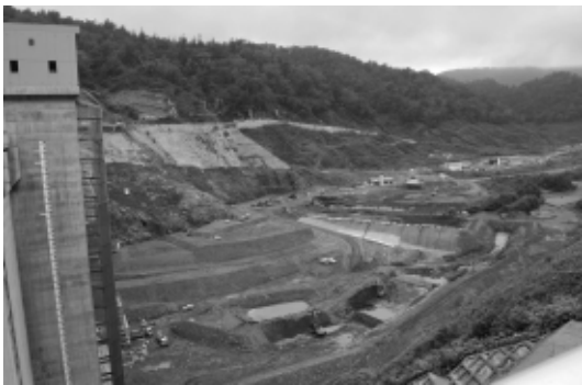
最終工事中の徳富ダム
