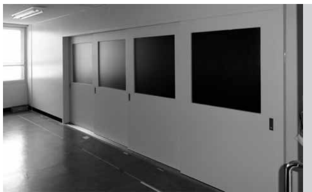
配膳室搬入口に引戸を設置し、児童の安全対策と暖房の効率化を図りました。
