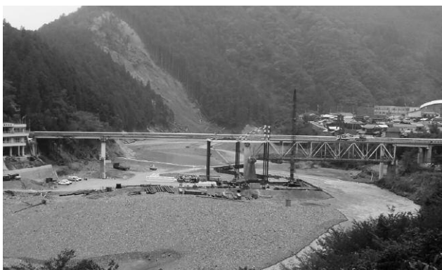
流された折立橋の復旧作業の様子
