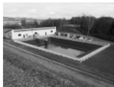
完成した民間の産廃施設
