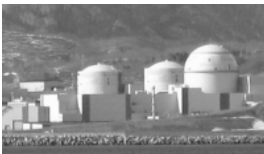
泊原子力発電所(左から1号機～3号機)
