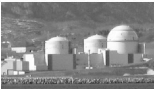
泊原子力発電所(左から1号機～3号機)
