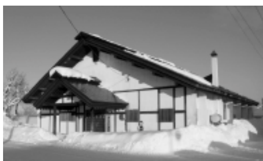
昭和48年に建てられた尚武館
