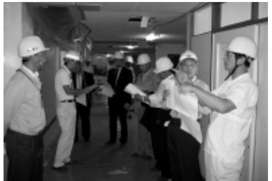
▷改修工事中の中学校
