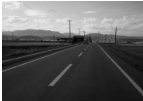
▷工事が完了した南7号線
