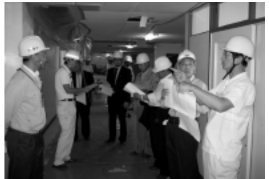
▷改修工事中の中学校
