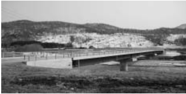
△完成した壮志橋
