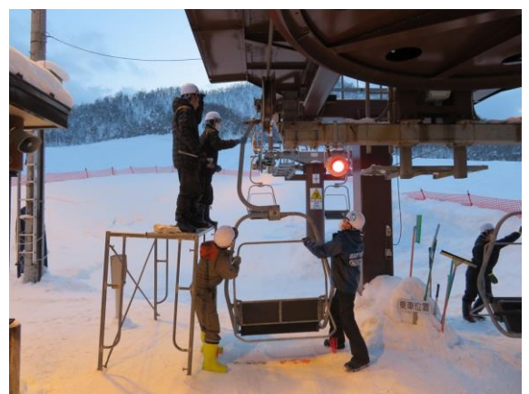
リフト定期整備（定期実施）の様子
