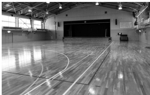
体育館の床を研磨し、塗装しました。窓枠内部にプレスを設置し、耐震性が確保されました。
