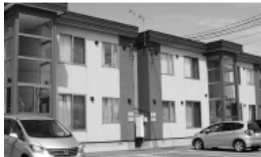
▲助成を受けて建設された共同賃貸住宅
